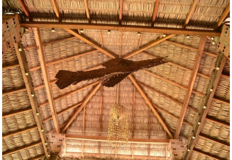
Imagem 5: Telhado com palhas de carnaúba Fonte: https://bit.ly/3f4HzWd
